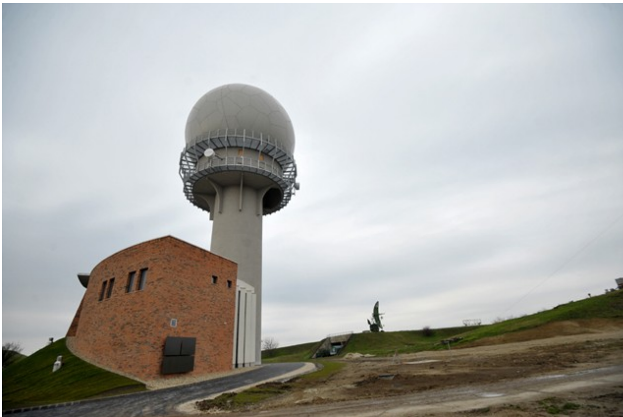
A radartorony és a kiszolgálóépület felépítéséhez 1166 köbméter betont és 205 tonna betonacélt használtak fel
