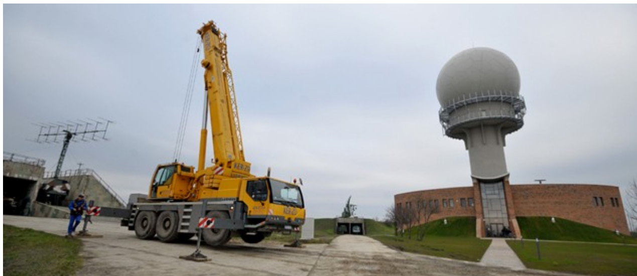
A betontorony 28 méter magas
