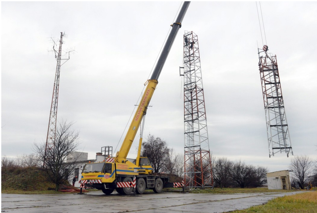
Bontják az egyik régi, ma már nem használt antennatornyot a medinai radarbázison 2014. január 15-én. A medinai 3D-s NATO-radar kiépítésének munkálatai a végéhez közelednek. Az új radartorony híradó-informatikai rendszerét integrálták az országos hálózatba, ezért a feladatot korábban ellátó antennákat és antennatornyokat elbontják. MTI Fotó: Kiss Dániel
